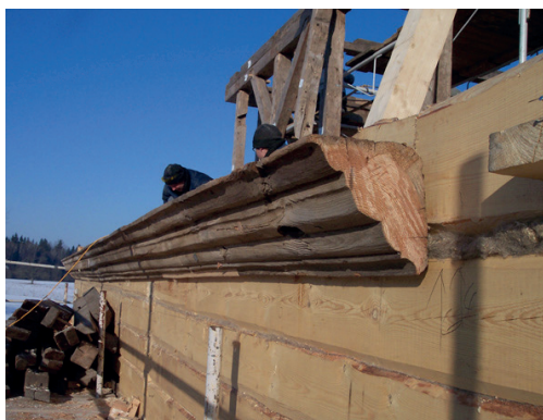
Il. 5. Gzyms pałacu dworskiego, 2015. Fot. R. Bertašiūtė.
