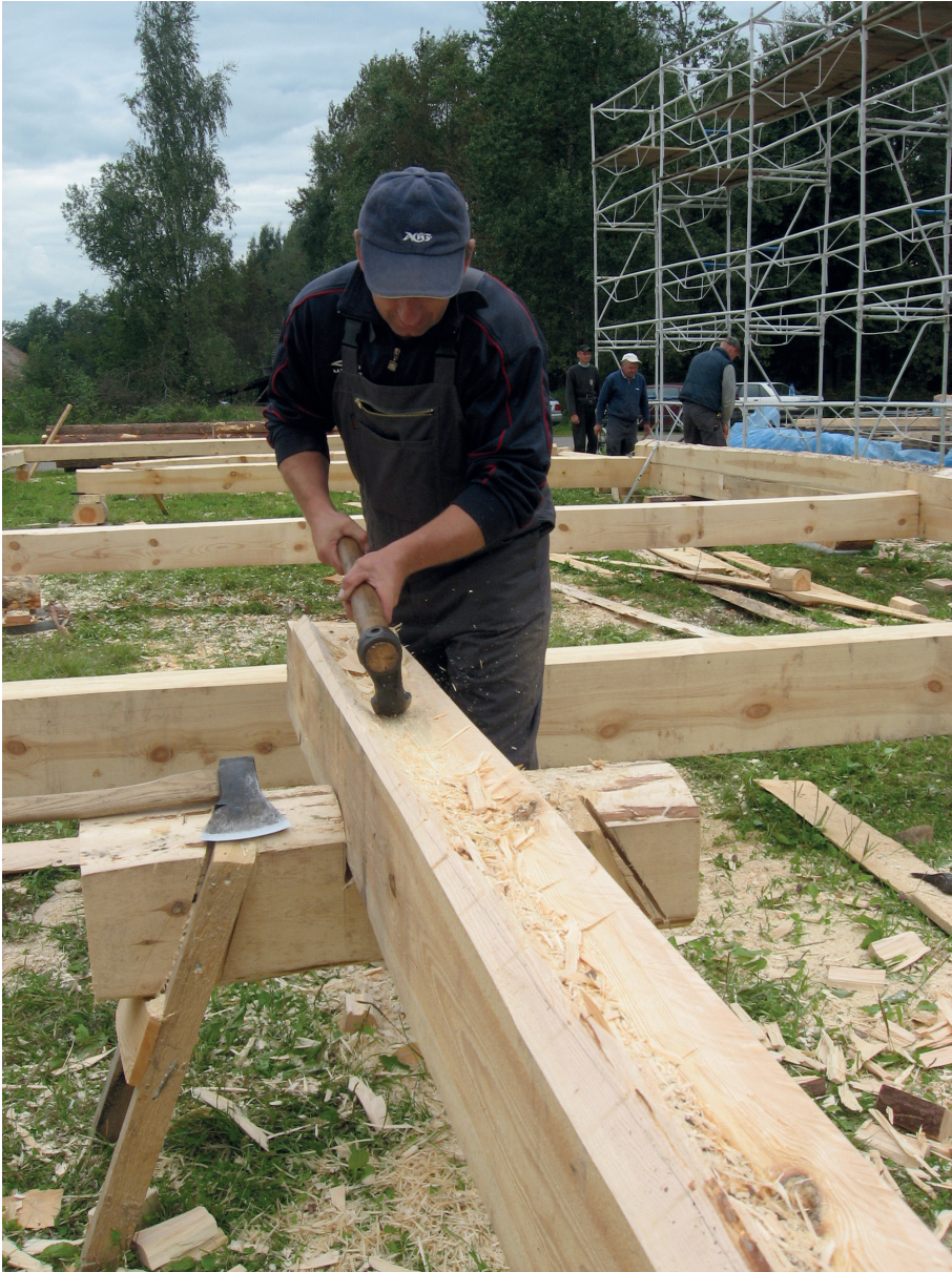
Il. 3. Drążenie bierwiona ściany dworskiej, 2010. Fot. R. Bertašiūtė.
