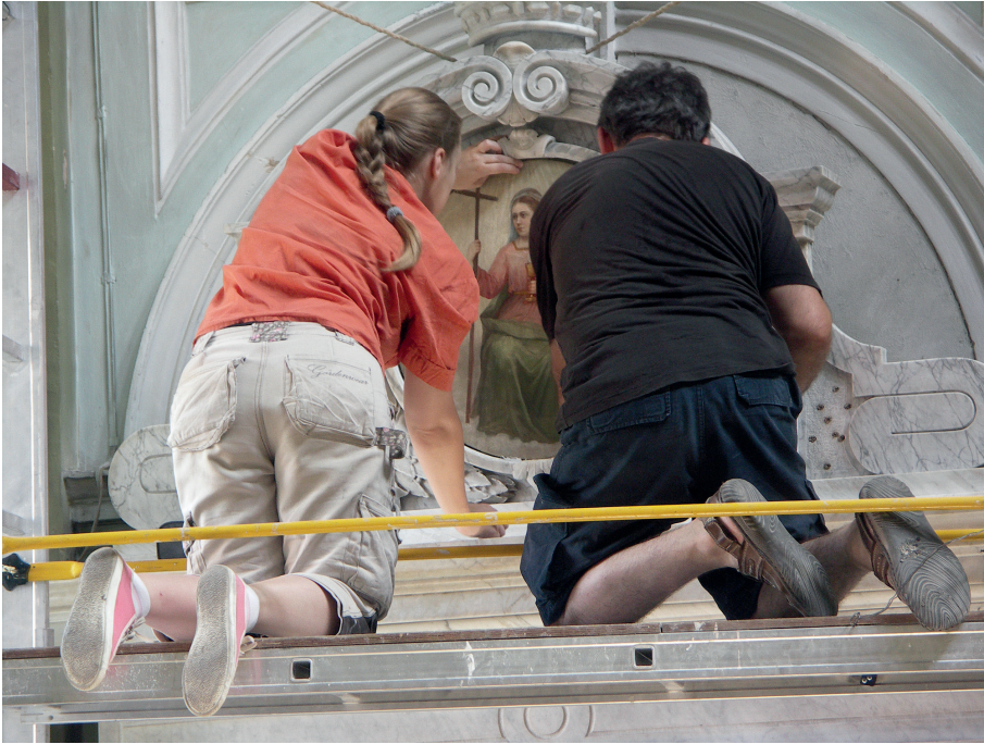
Il. 13. Ołtarz w trakcie prowadzenia prac konserwatorskich. Fot. E. Welter.
