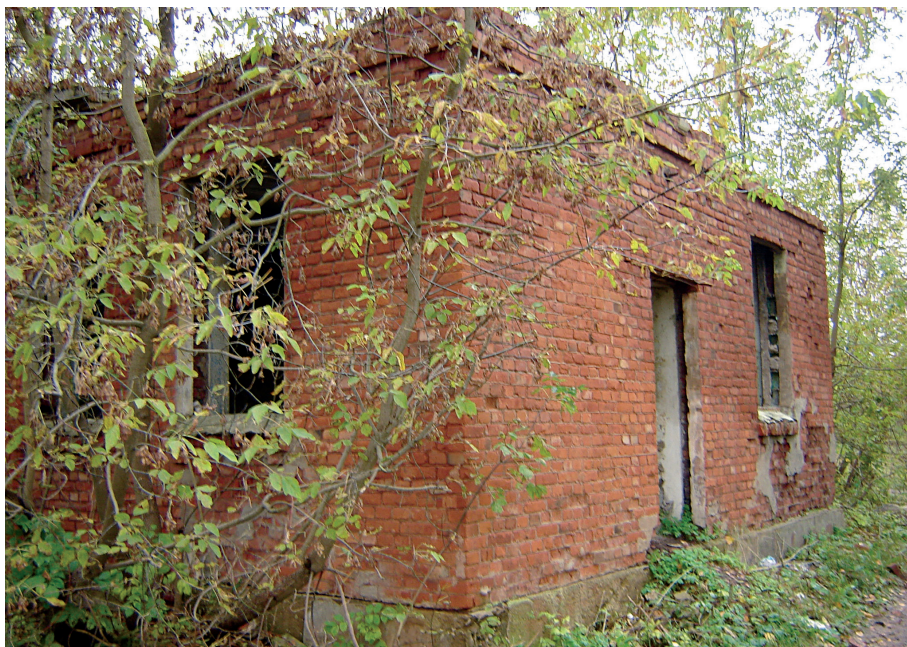
Il. 5. Ruiny fabryki, 2012 r. Fot. D. Rembiszewska.
