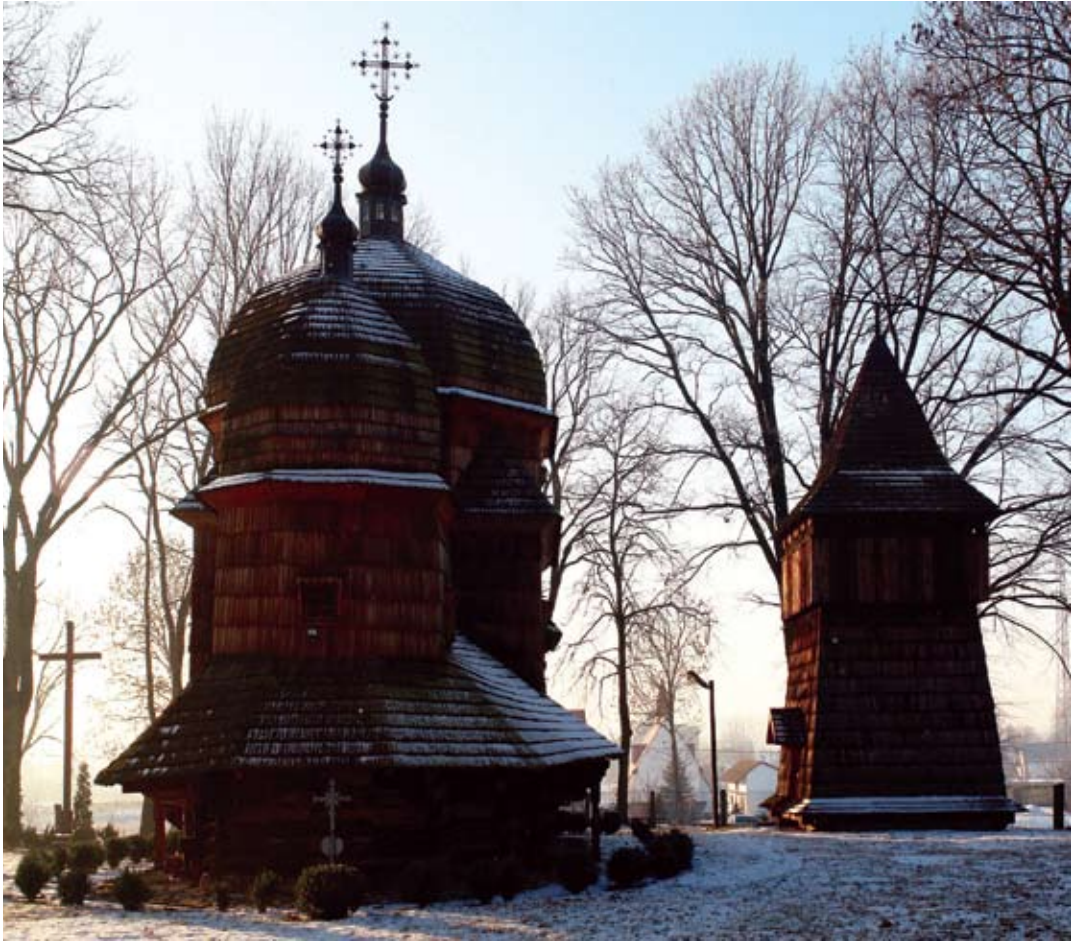
5. Chotyń – cerkiew po remoncie + dzwonnica przeniesiona z Terek.
