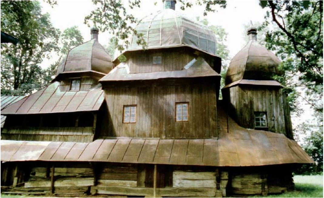
3. Chotyńiec – cerkiew z 1613 r. przed remontem
