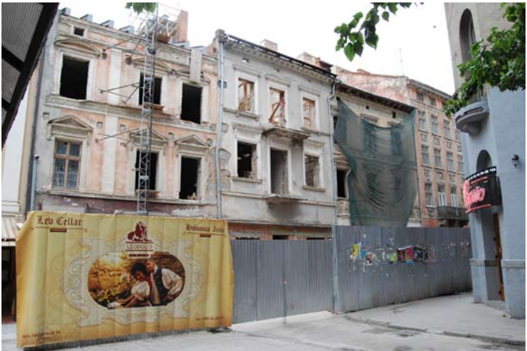
3. Lwów, przyrynkowa zabudowa miasta lokacyjnego wpisanego na Listę Pomników Kultury UNESCO, XVII wieczne kamienice w trakcie częściowej rozbiórki i przebudowy na hotel. Fot. J. Lewicki 2009.
