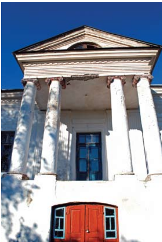
il.20. Pałac w Bieleckiem, portyk elewacji bocznej, fot. autorka, 2008
