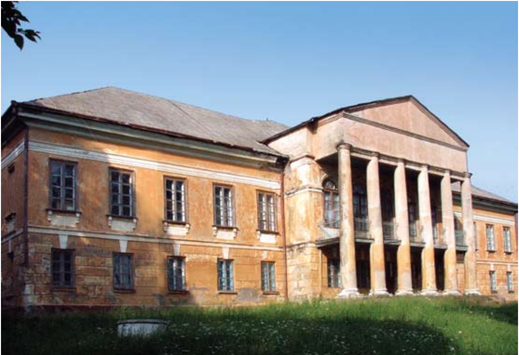
il.5. Pałac w Międzyrzeczu Koreckim, elewacja ogrodowa, fot. autorka, 2007
