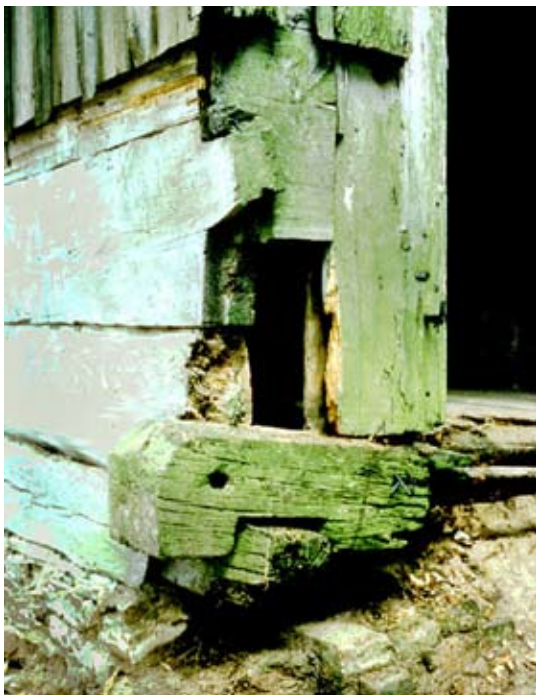
Mięksisz Stary (gm. Laszki), opuszczona cerkiew z r. 1803-11 – fragment zmurszałego zrębu ścian /fot. autor/
