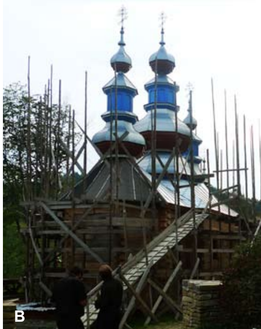
Komańcza (gm. Komańcza, pow. Sanok), cerkiew z 1802 r.; a – stan z lat 60. XX w. /fot. M. Kornecki/, b – w trakcie odbudowy po spaleniu w 2006 r. /fot. autor, 2009 r./
