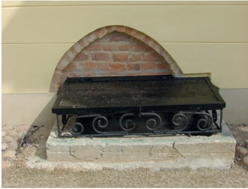
Ilustracja 8. Ostrołukowe okienko piwniczne w elewacji ogrodowej pałacu.
