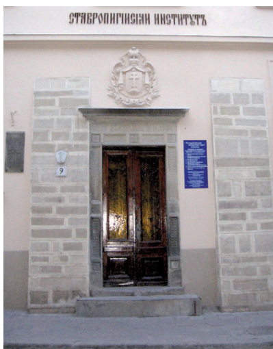
Il. 2. Budynek Instytutu Stauropigialnego – wejście (ul. I. Fedorowa 9). Zdjęcie współczesne.
