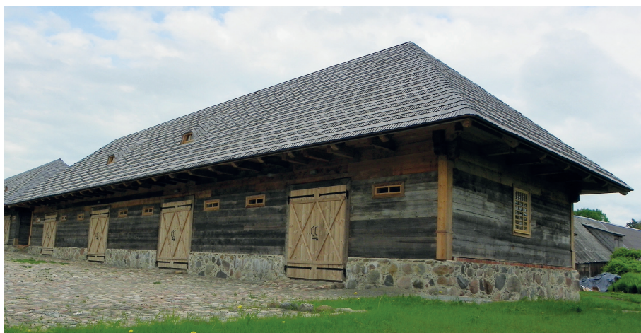
Il. 13. Stara stajnia przed rewitalizacją i po niej. Fot. D. Puodziukienė, 2004 i 2013.
