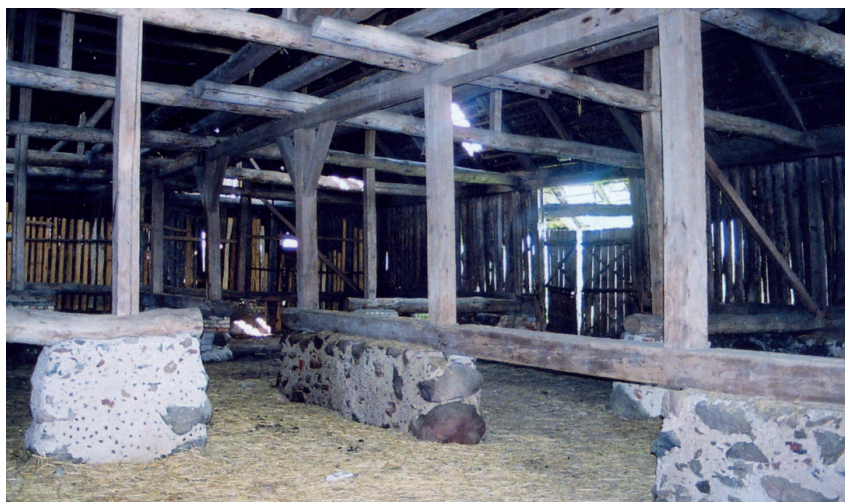
Il. 16. Drewniana stodoła z mostami wjazdowymi: a) widok ogólny budynku (fot. A. Jankevičienė, 1965), b) przekrój, c) wnętrze stodoły (fot. D. Puodžiukienė, 2008).
