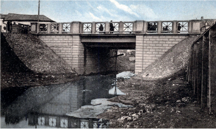
Il. 8. Most Kazimierza Wielkiego, poczłówka, ok. 1925. Fot. nieznaną, Biblioteka Narodowa.
