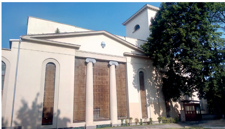
Il. 2. Budynek laboratoryjny Wydziału Mechanicznego Politechniki Lwowskiej. Projekt B. Stefanowskiego, biuro architektoniczne Derdacki i Minkiewicz, 1914; W. Minkiewicz, 1921. Bud. B. Stefanowski, biuro architektoniczne Derdacki i Minkiewicz, 1914; W. Minkiewicz, 1925–1927. a – widok ze strony wschodniej; b – widok ze strony północnej. Fot. S. Linda, 2016.
