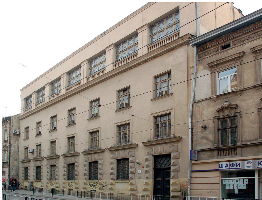
Il. 21. Jeden z pierwszych budynków przemysłowych Lwowskiej Szkoły Architektonicznej wzniesiony w zwartej zabudowie – gmach Polskiej Akcyjnej Spółki Telefonicznej, ul. Sykstuska 26 (ob. P. Doroszenki, ukr. Петра Дорошенка), 1925–1927, proj. Eugeniusz Czerwiński, nadbudowa 3 piętra proj. Bolesław Neyman 1935, widok ogólny.
