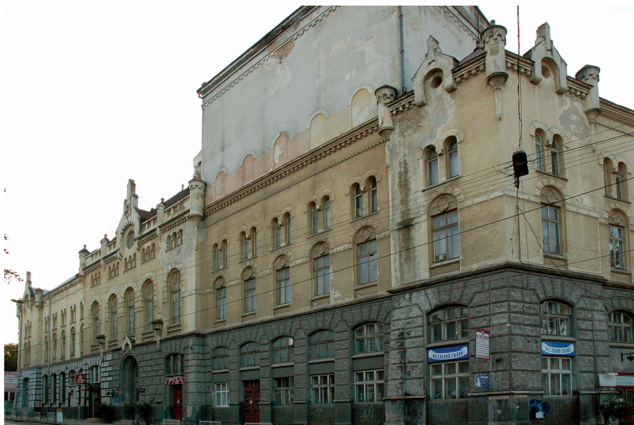
Il. 7. Budynek w stylu historyzmu Lwowskiej Szkoły Architektonicznej – gmach Domu Katolickiego ul. Gródecka 36 (ukr. Городоцька), 1911, proj. Adam Opolski, Ignacy Kędzierski, widok ogólny.
