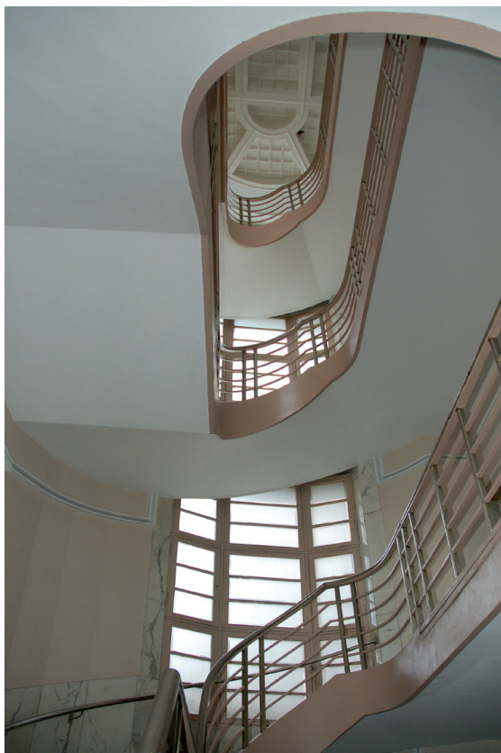
Il. 25. Pierwszy wielki nowoczesny budynek Lwowskiej Szkoły Architektonicznej – kamienica Sprechera, ul. Akademicka 7 (ob. Pr. Szewczenki, ukr. проспект Тараса Шевченка), 1928, proj. Ferdinand Kessler, realizacja do 1931 roku. A. Widok ogólny; B. Klatka schodowa.
