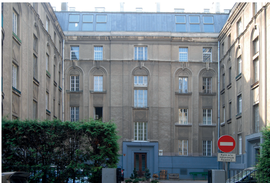
Il. 27. Zespół budynków mieszkalnych Lwowskiej Szkoły Architektonicznej – domy pracowników Uniwersytetu Jana Kazimierza, ul. Supińskiego (ob. M. Kociubińskiego, ukr. Михайло Коцюбинського) 11/13, projekt biuro Mariana Nikodemowicza i Mieczysława Stadlera 1925, realizacja do 1927 roku, widok ogólny.
