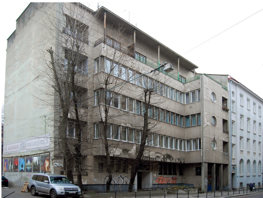
Il. 34. Funkcjonalistyczny budynek mieszkalny Lwowskiej Szkoły Architektonicznej – Lwów, ul. Władysława Łozińskiego 5 (ob. ulica Aleksandra Hercena, ukr. Олександра Герцена), 1938–1939, proj. Ferdynad Kasller.
