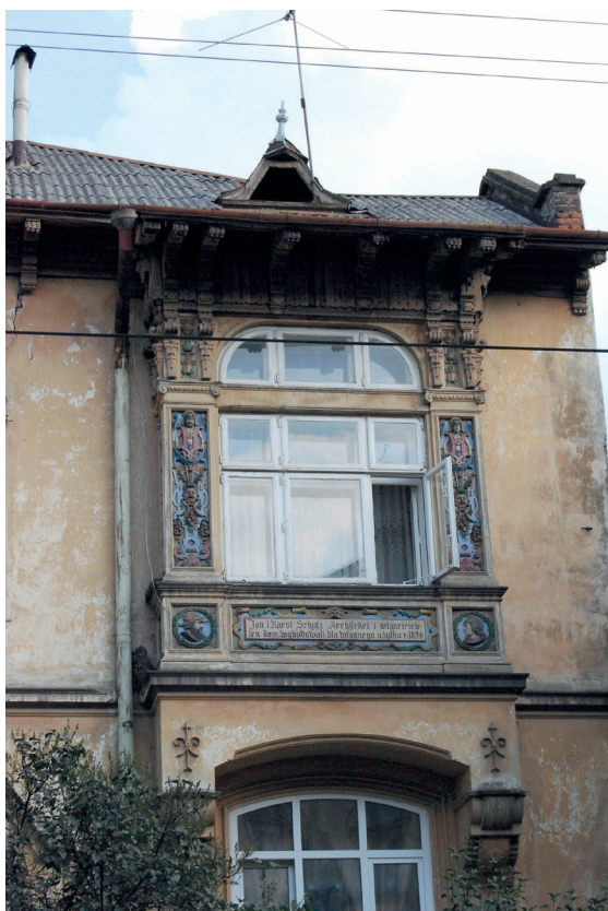
Il. 6. Dom własny architektów Jana i Karola Schulców, 1896, ul. Żółkiewska 56 (ob. Chmielnickiego, ukr. Бордана Хмельницького). A. Widok ogólny; B. Środkowa część elewacji.
