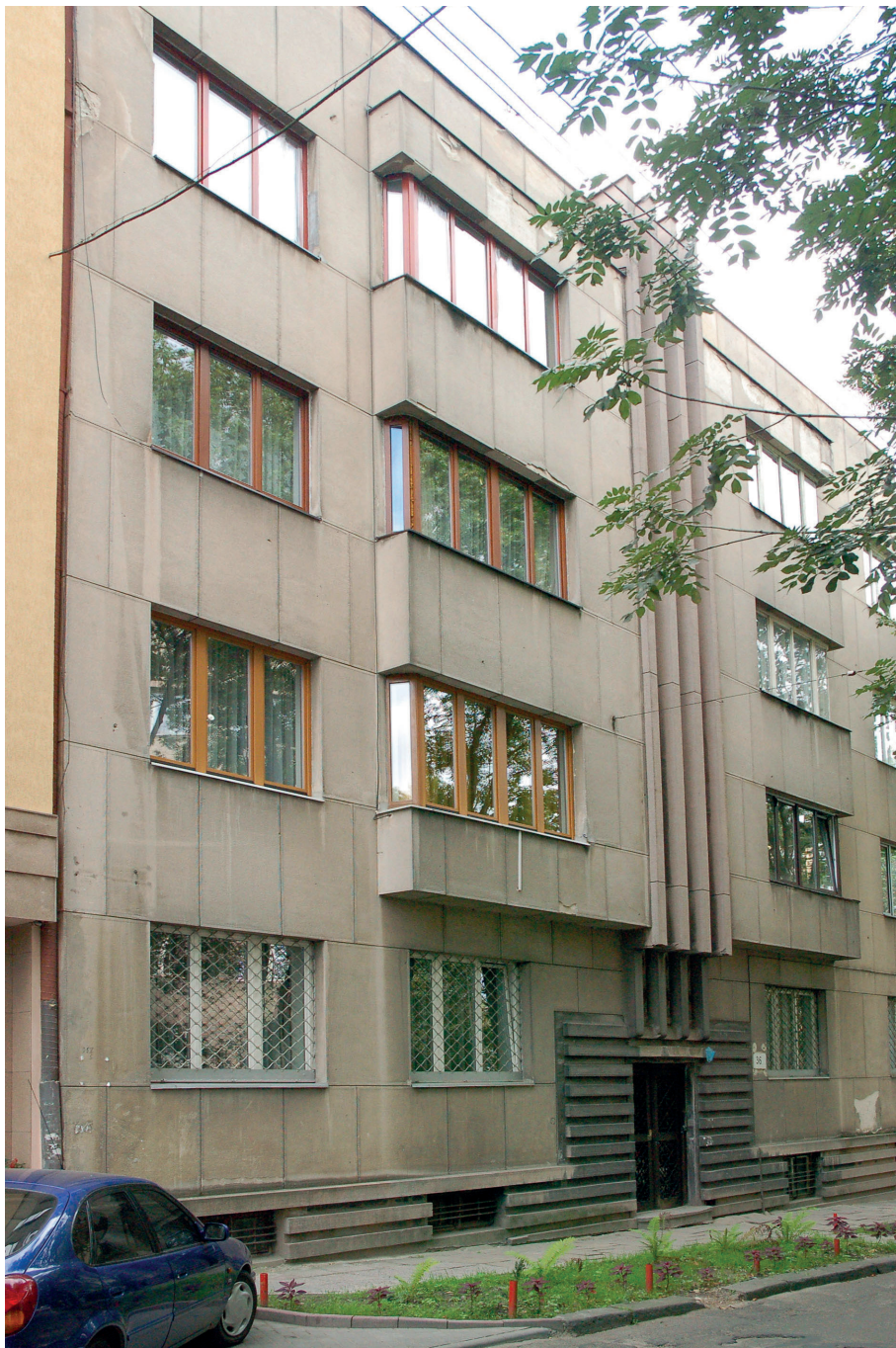
Il. 35. Najwybitniejszy budynek mieszkalny Lwowskiej Szkoły Architektonicznej – Lwów, ulica Sakramentek 36 (ob. M Tugan-Baranowskiego, ukr. Михайла Туган-Барановського), proj. Ryszard Hermelin 1937, realizacja do 1938 roku. Widok ogólny.
