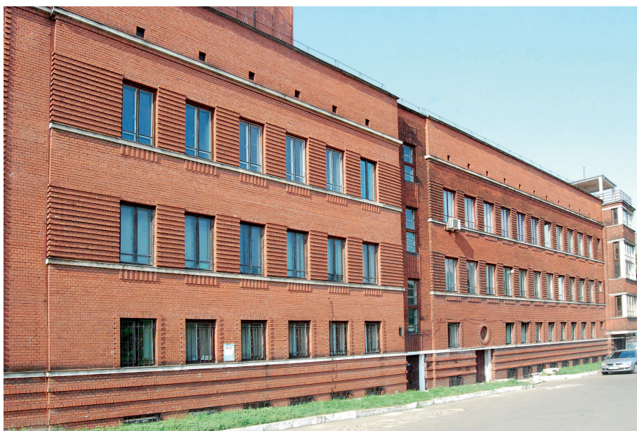
Il. 43. Przykład budynku Lwowskiej Szkoły Architektonicznej z rozbudowanym programem społecznym – Dom Związku Pracowników Gminnych Miasta Lwowa wraz z Kinoteatrem Światowid, ul. Samuila Kuszewycza 1 (obecnie ulica Serafyma Kuszewycza), 1933–1938, proj. Tadeusz Wróbel i Leopold Krasiński. Widok ogólny i elewacja boczna.
