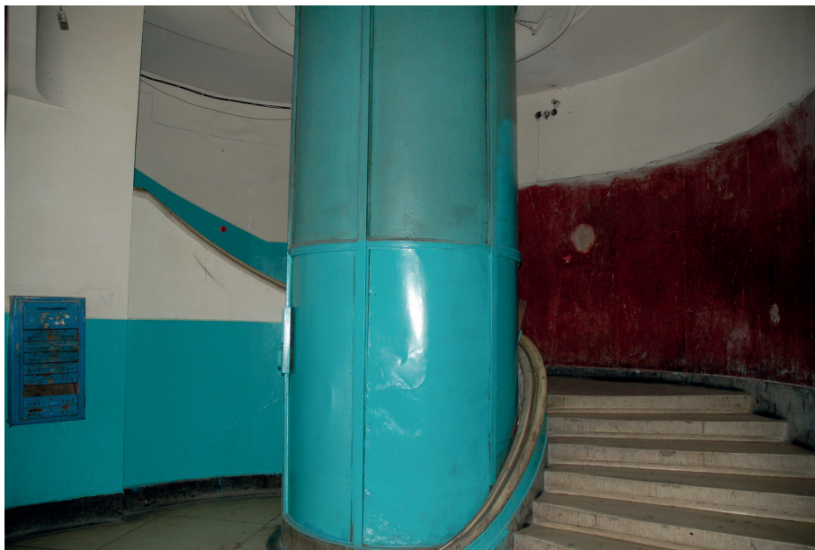
Il. 33. Jeden z ostatnich luksusowych budynków Lwowskiej Szkoły Architektonicznej wzniesionych przed II wojną światową, gmach Izby Notarialnej (zwany też Domem Notariuszy), ul. Romanowicza 6 (ob. P. Saksagańskiego, ukr. Панаса Саксаганського), proj. Zbigniew Wardzała w biurze Stanisława Rożyckiego 1937–1938, realizacja do 1939 roku, klatka schodowa.
