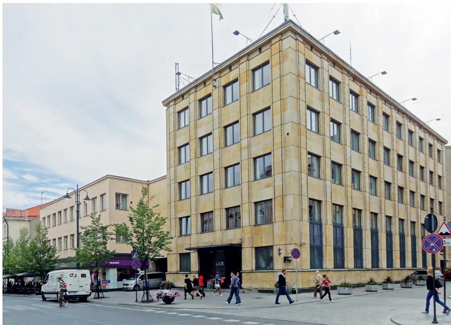
Il. 38. Gmach Pocztovej Kasy Oszczędności, arch. Juliusz Żórawski i Zbigniew Puget. Fot. Małgorzata Dolistowska, 2012 r.
