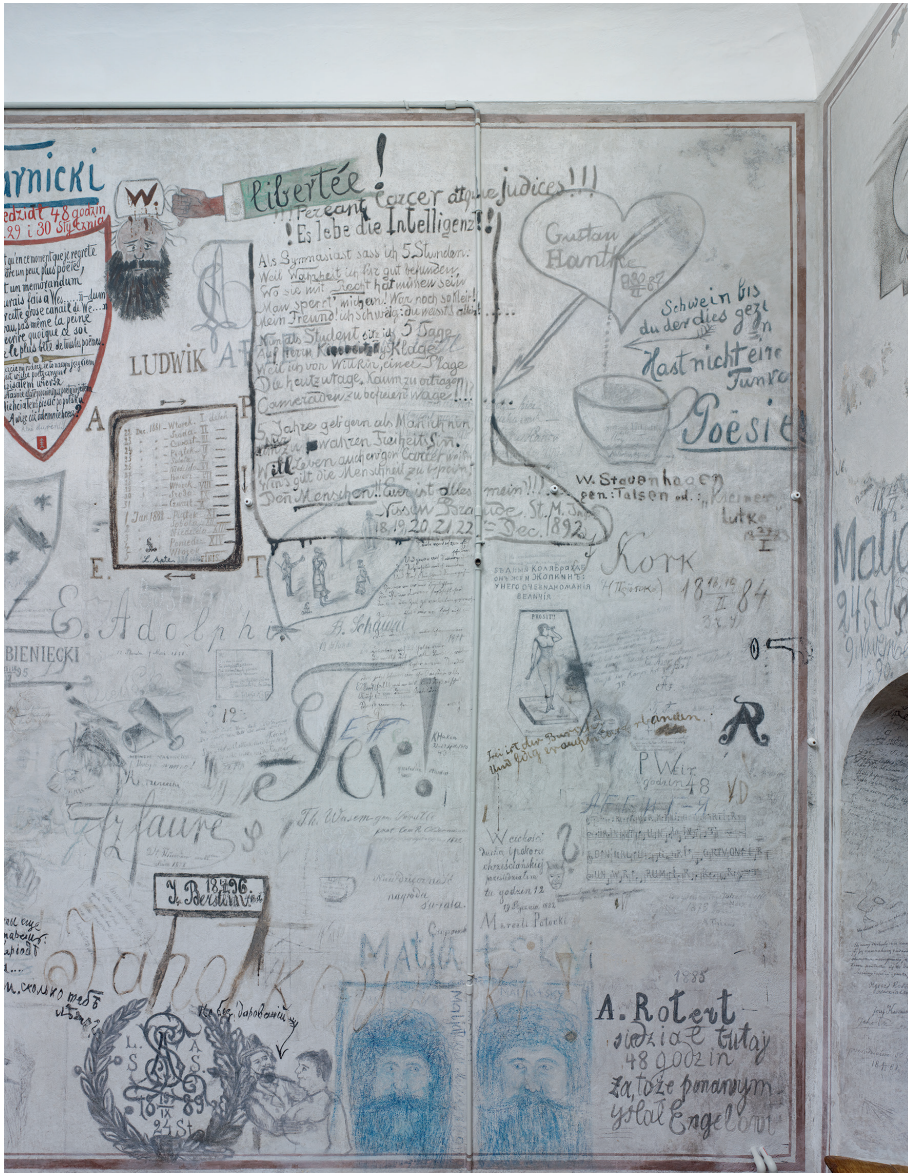
Il. 11–18. Karcer po pracach konserwatorskich w 2011 r. Fot. Jakub Certowicz.
