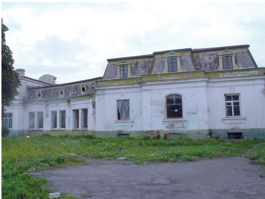
Il. 18. Pałac w Antoninach, elewacja frontowa, Fot. W. Brzezińska, 2008 r.
