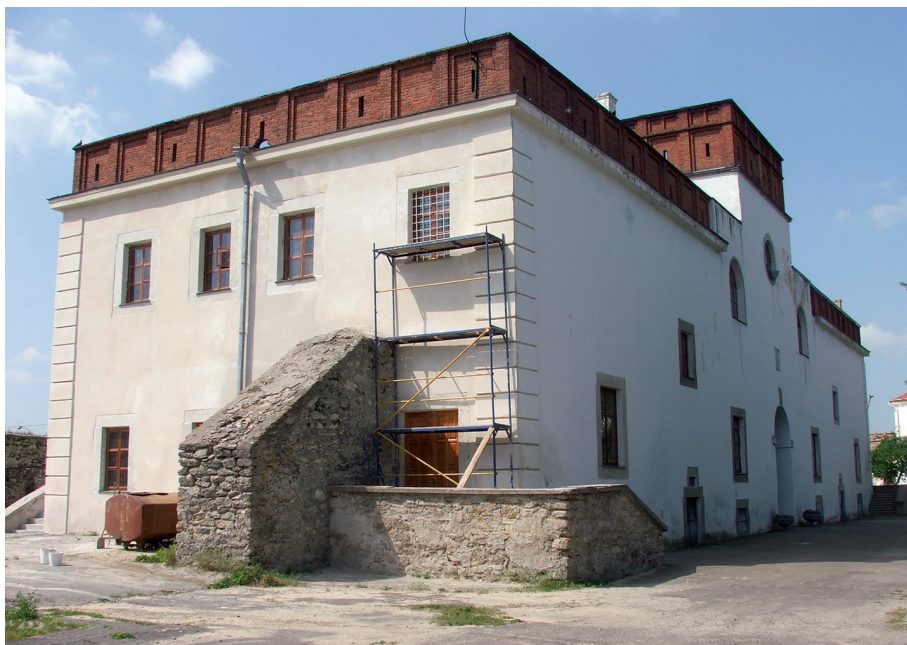
Il. 4. Zamek w Dubnie, budynek bramny. Fot. P. Dąbrowski, 2007 r.
