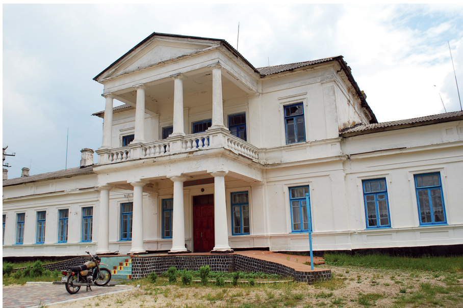
Il. 15. Pałac w Tynnem, elewacja frontowa. Fot. W. Brzezińska, 2011 r.
