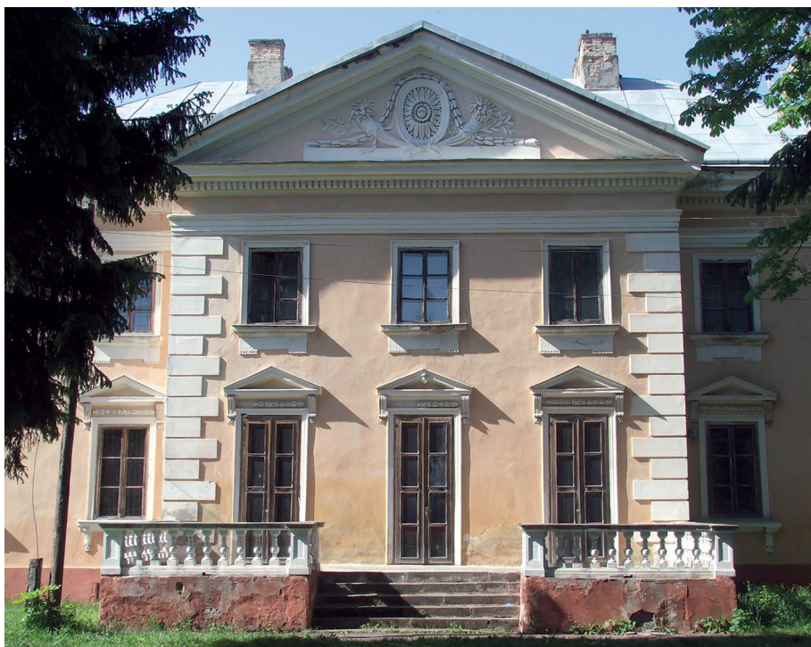
Il. 12. Oficyna w Młynowie, elewacja ogrodowa. Fot. W. Brzezińska, 2008 r.
