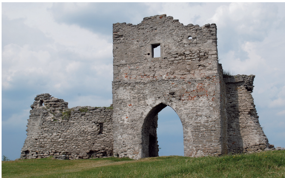
Il. 1. Zamek w Krzemieńcu, wieża bramna. Fot. W. Brzezińska, 2011 r.
