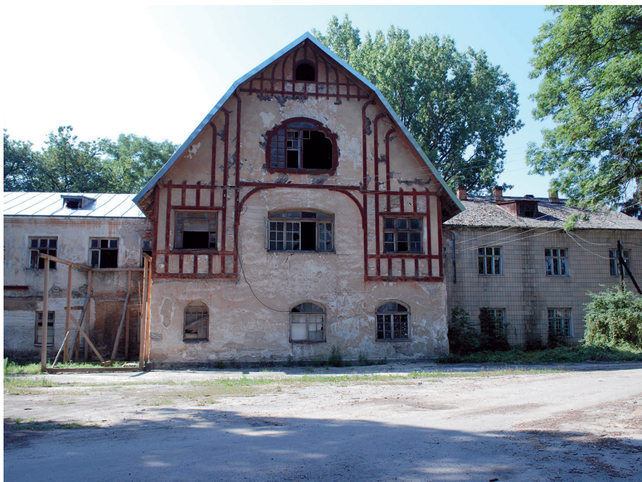
Il. 22. Pałac w Hoszczy, elewacja ogrodowa. Fot. P. Dąbrowski, 2008 r.
